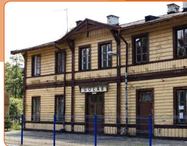
Stacja kolejowa w Gołębiu
